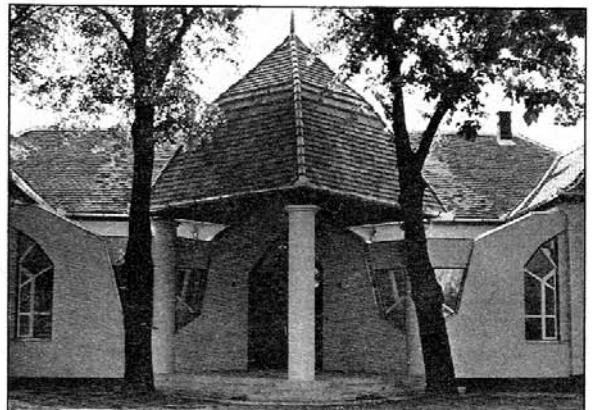
Balatonszemes, tanácsháza átalakítás és bővítés, Lőrincz Ferenc
