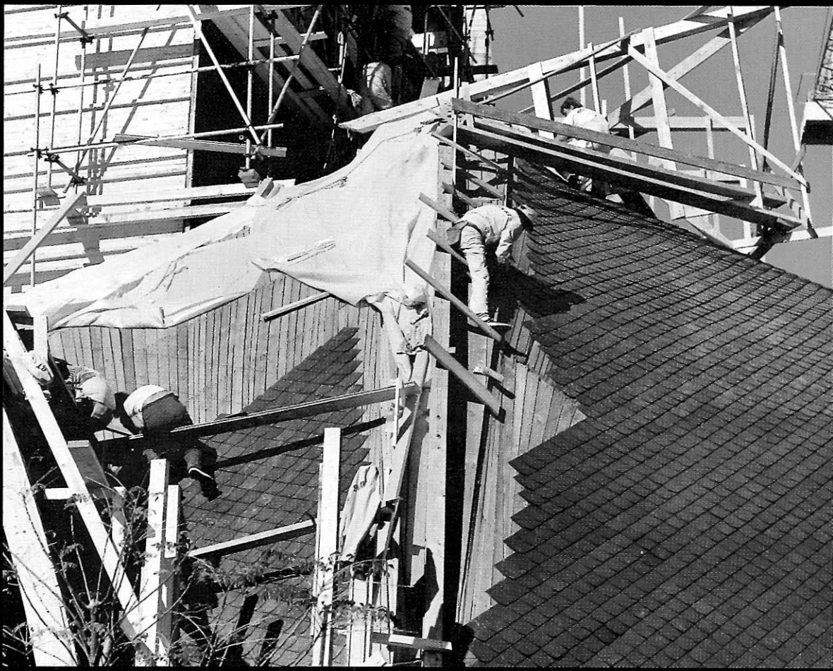
SETTING UP THE THIRD RIB AND THE SLATE COVERING A HARMADIK BORDA BEALLITÁSA ÉS A PALÁZÁS
