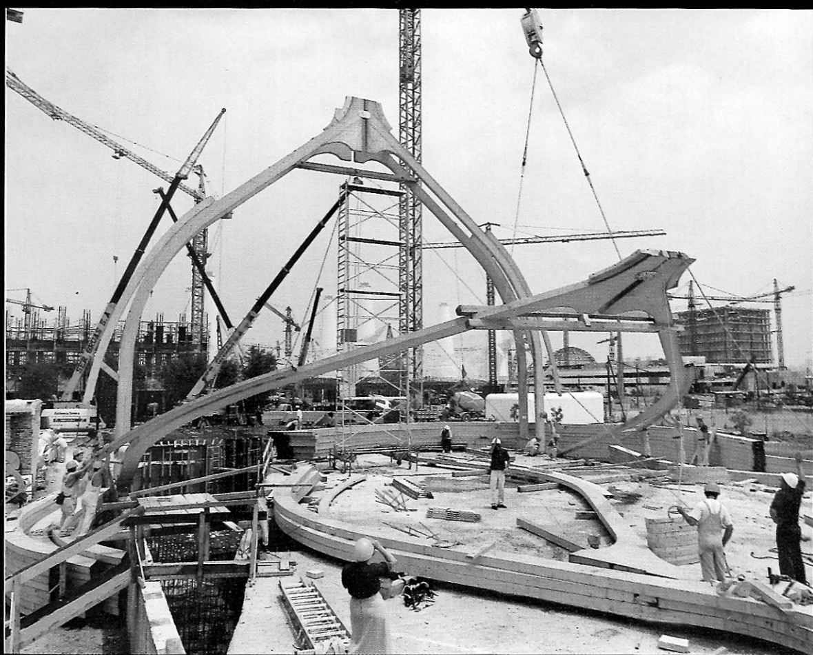
SETTING UP THE THIRD RIB AND THE SLATE COVERING A HARMADIK BORDA BEALLITÁSA ÉS A PALÁZÁS
