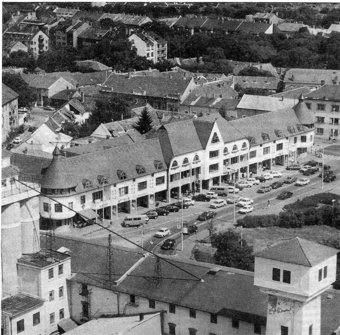
Főtér Északi Térfal Üzletház, Kecskemét (B. Tóth Jánossal)
