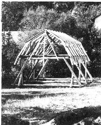
Fafaragóház, 1978-80, és az építők egy csoportja Fásszín – 1981, építés közben – és készen
