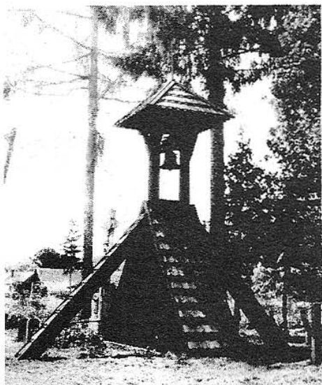
Farkasfa (Vas) kétoszlopos, talpgerendás, támasztetős, zártházás harangláb, 1993 (s. csoport)
