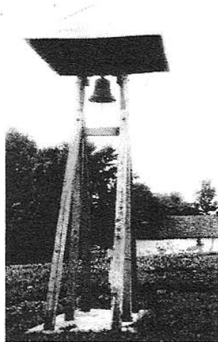
Bagod (Zala) kétoszlopos, beásott, hagyományos harangláb magas lengőtámaszokkal, 1993, (d. csoport)
