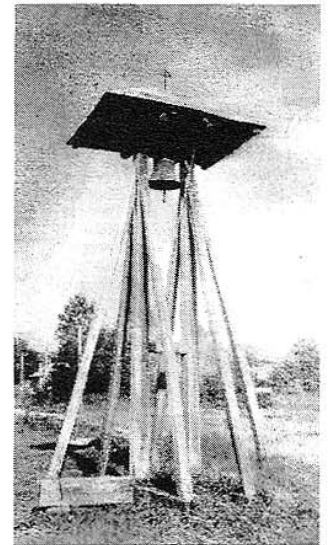
Hottó (Zala) kétoszlopos, talpgerendás, vázas harangláb lengő- és oldaltámasszal, 1975 (p. csoport)
