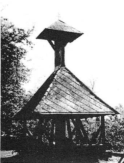
Ritkaháza (Vas) kétoszlopos, beásott, szoknyás, vázas harangláb, 1994 (készült 1820 körül, í. csoport)
