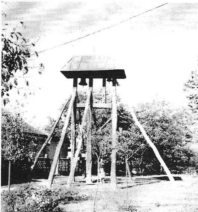
Hánta (Komárom-Esztergom) háromszlopos, földbe ásott, nyitott, lengő-és oldaltámaszokkal megerősített hagyományos harangláb 1986 (b. csoport)
