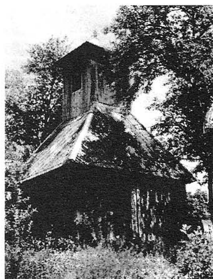
Szilvágy (Zala) kétoszlopos, talpas, zártsocknyás, műemlékjellegű harangláb utólag épült, zárt harangházzal 1993 (v. csoport)
