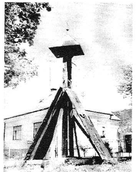
Máriaújfalu (Vas) kétoszlopos, talpas, támasztetős, oldalt nyitott harangláb, 1975 (r. csoport)
