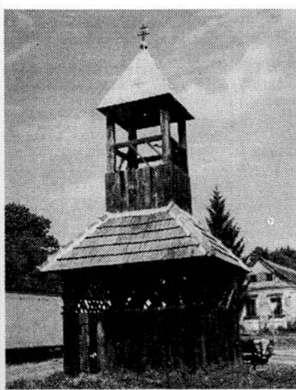
Szijártó háza (Zala megye) négyoszlopos, talpas, négyoldalú, zárt szoknyás, zárt harangházi, zártházás harangláb, 1987 (q csoport)
