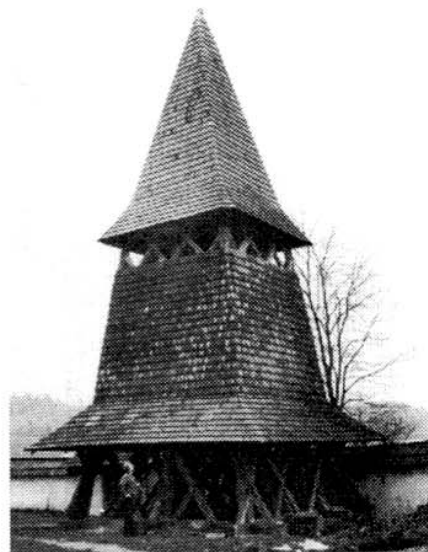
Cserény (Felvidék) sajátosan terpesztett idomú, tizenkét oszlopos, kötényes harangtorony, 1993 (s csoport)
