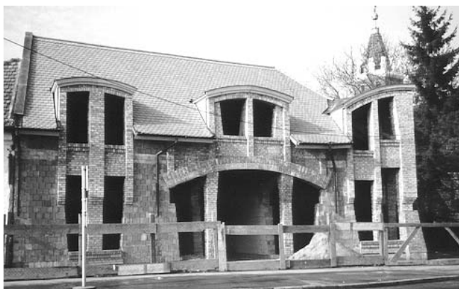
Csernyus Lőrinc: épülő csegeri üzletház, 1998
