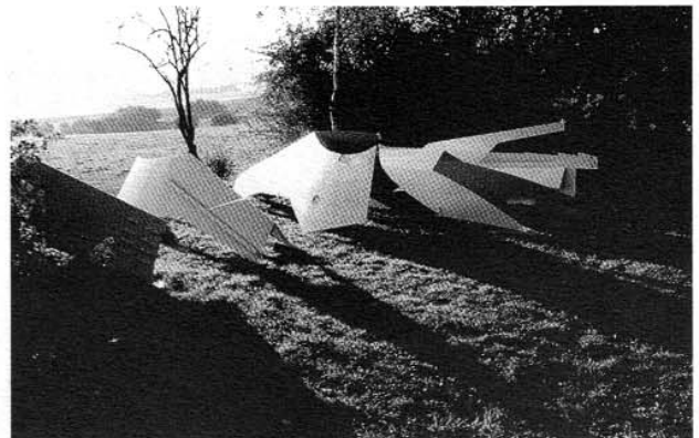
Ouffet, az építkezés helyszínére szállított fémlemez-elemek beállítás előtt. (Ezek, és a következő képek Sáros László felvételei.)
