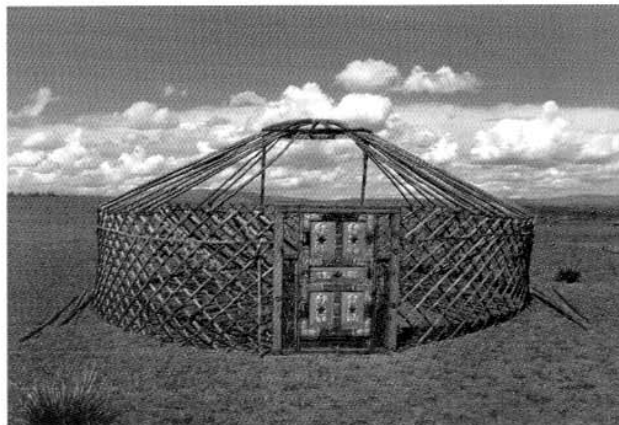
Lakodalomhoz felállított alkalmi jurta a nemezborítás ráhelyezése előtt
