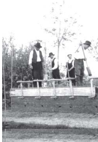
Vert vályogfal készítése kalodában
