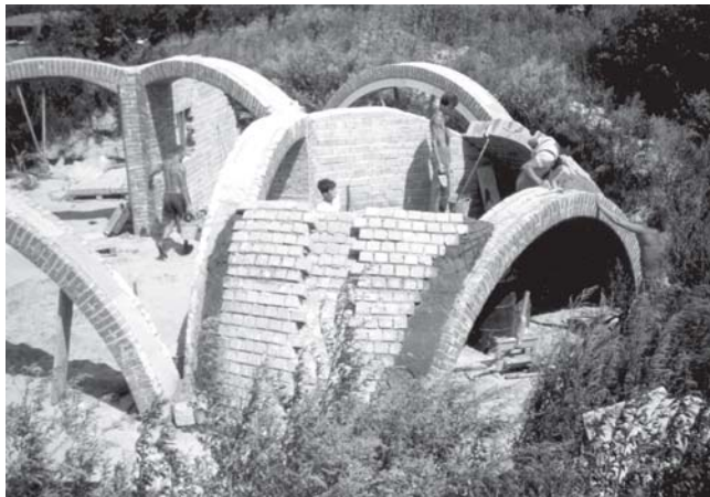
Gömbkupolás lakóház építés közben - Tököl
