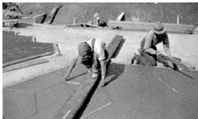
A sejt-hálózatot fémsablonnal belenyomják az alapbetonba (Hanna-ház)
