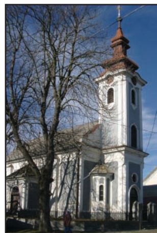
Somogyaszaló, református templom helyreállítása
