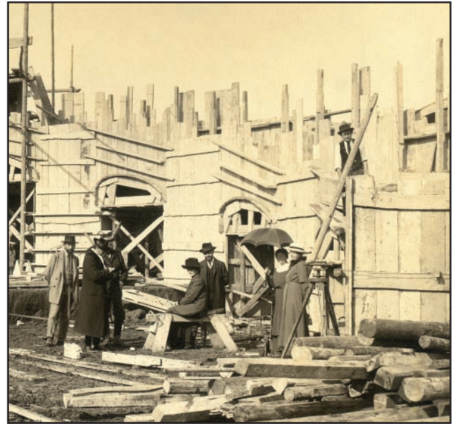
A beton aléptítmény építés közben, 1913 októberében; lent: a kész épület a jurai tájban
