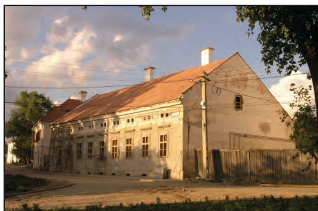
Csíkszereda, örmény kereskedő háza – helyreállítás 2006
