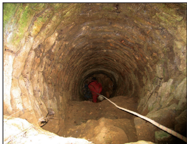
Az ázsiai qanat-rendszerű vízgyűjtő hosszmetzeti ábrája; illetve fényképek a qanat-rendszer szellőzőkürtőinek megfelelő elemekről a fel-tételezett fehéregyházi település területén.
