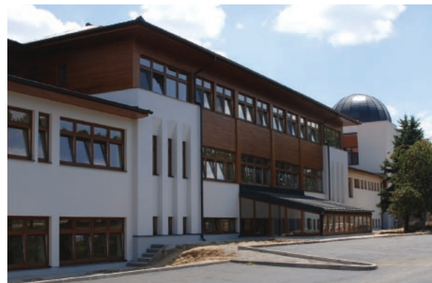
Bonyhád, szakorvosi rendelő és sebészeti épület, bővítése és felújítása
