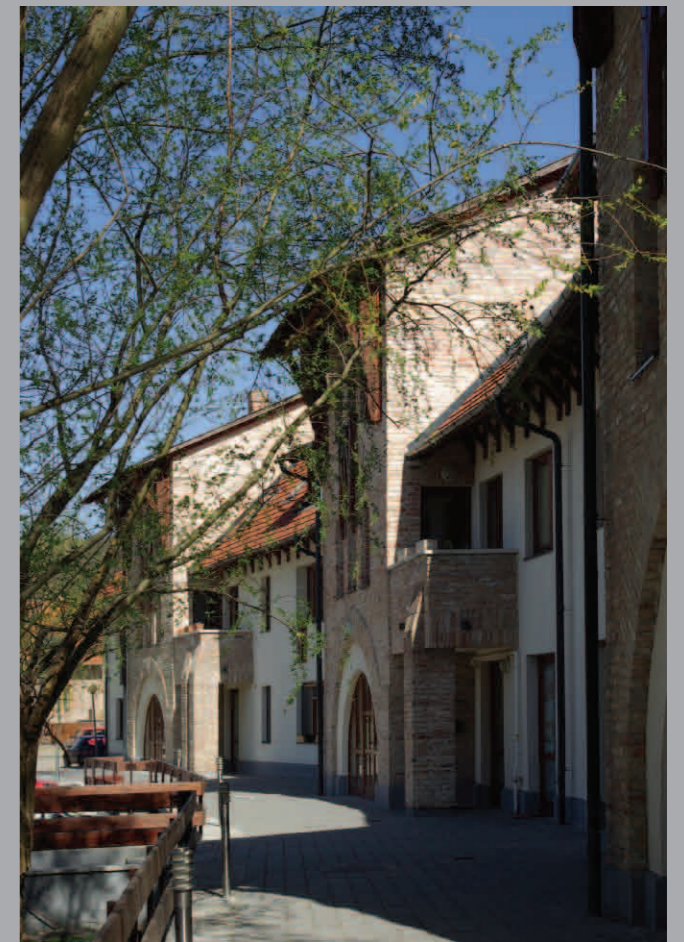
Píliscsaba, Fényesliget, 48 lakás üzletekkel • tervezés: 2005, kivitelezés 2007 • Az épület a patakmeder vonalát követi. Három, egymáshoz szögben csatlakozó tömegeből áll. A két egyforma szélső egy eltérő középső tömeget fog közre. A hossz-homlokzatok más karakterűek. A „hasas”, lágy formálású néz az organikus épületekre, az egyetem felé. A „horpadt” homlokzat néz Píliscsaba felé, ez kemény formálású, téglalburkolatos, németes-svábos. A lakásokhoz nagy teraszok épültek.
