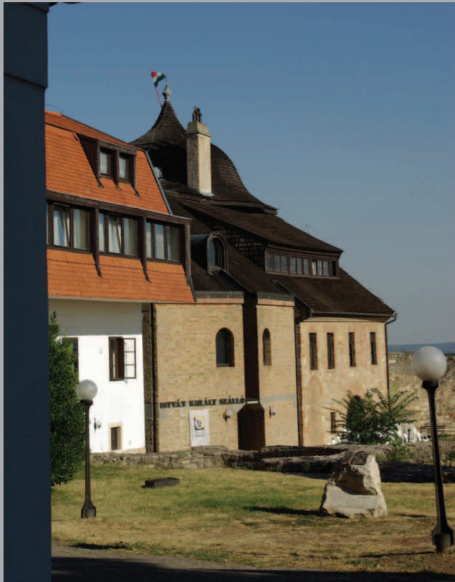
Pécsvárad, István király szálloda • tervezés: 1982, kivitelezés: 1985 • A szálloda a vár területén épült, a meglévő barokk épületek kétszintes tetőtérbeépítésével és bejárati épülettel. A bejárati építmény az ágyútorony és a várfal mellett húzódó hosszanti épületek közé került. Az épületben 45 kétágyas szoba található, konyháuzemmel, étteremmel a földszinten.
