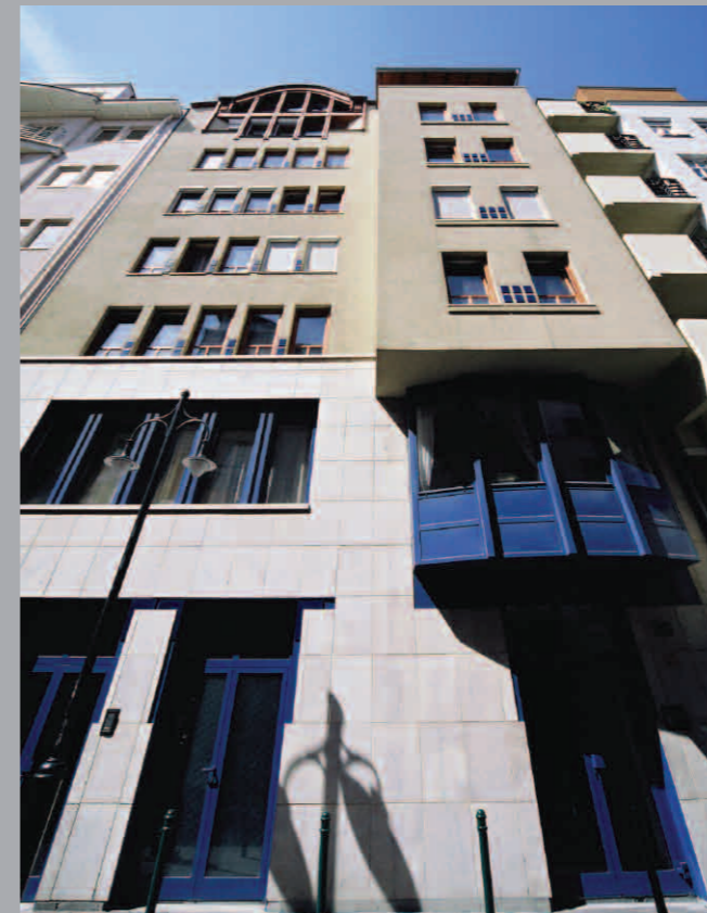
Lakó- és irodaépület • Budapest, IX., Angyal utca 26. • tervezés: 2000, kivitelezés: 2001 • A Sissi szállodával közel szemben épült kilencszintes lakóépület, földszintjén és első emeletén irodákkal. Az épületben a további szinteken 18 lakás található, garzonlakástól a 120 m 2 -es lakásig. • 2002-ben elnyerte a SEM IX. Városfejlesztő Rt. pályázatán a pályázatán a második díjat.
