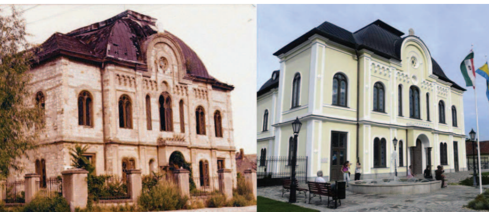
Farkas Pál: Zsinagóga helyreállítása, Tokaj 2006
