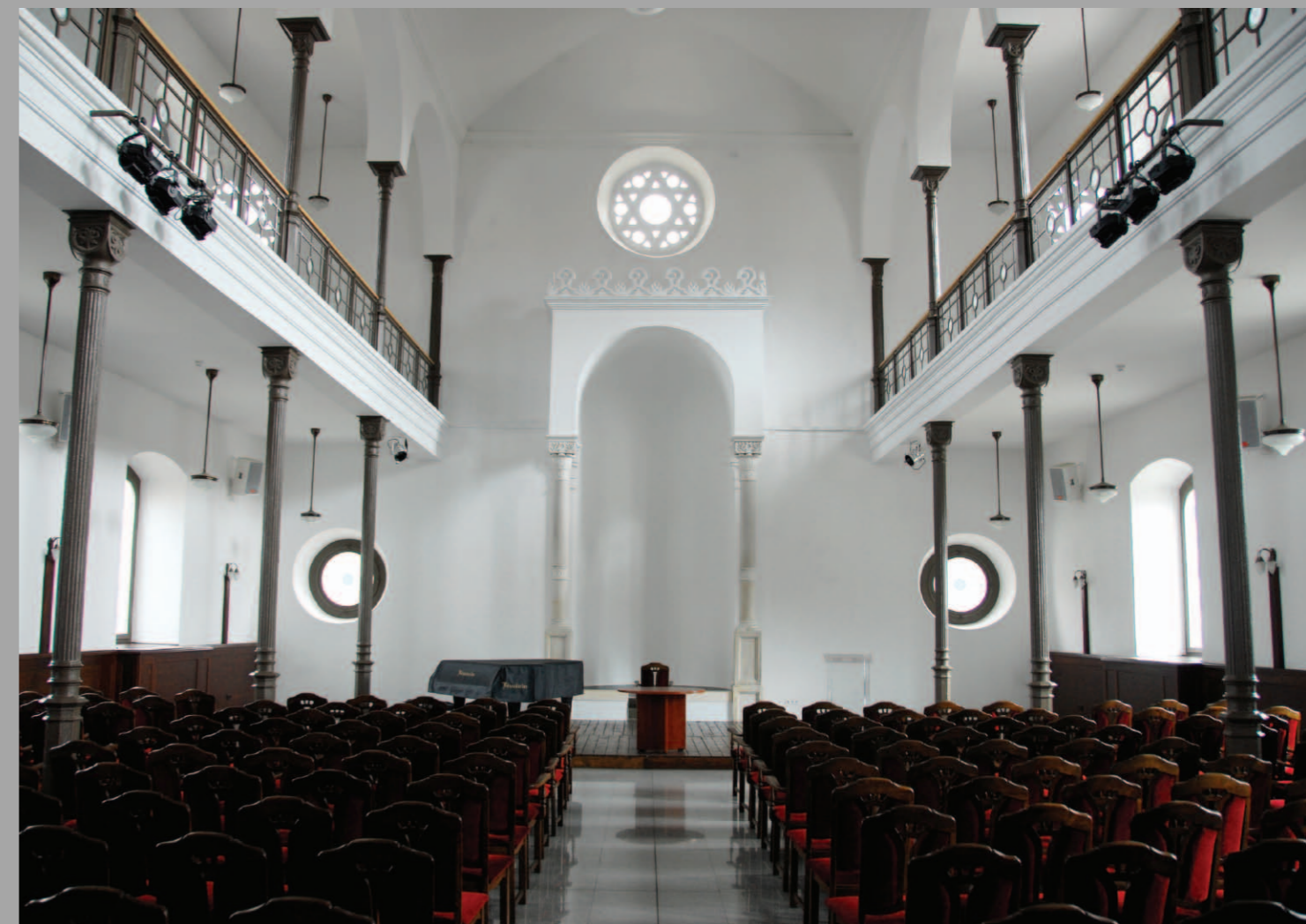
Farkas Pál: Zsinagóga helyreállítása, Tokaj 2006
