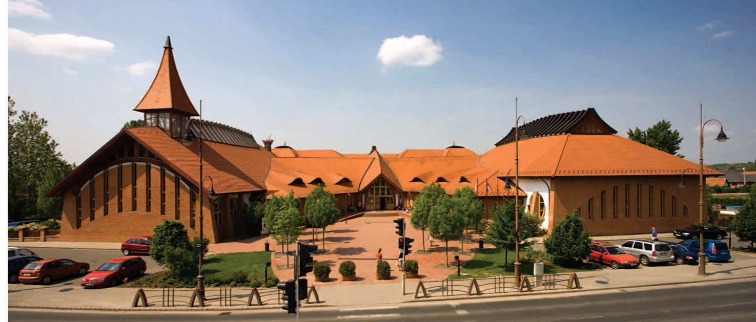
Mézesvölgyi Általános Iskola, aula, tornaterem és uszoda, Veresegyház, Zsigmond László, 2000-2003 fotó: Bujnovszky T.
