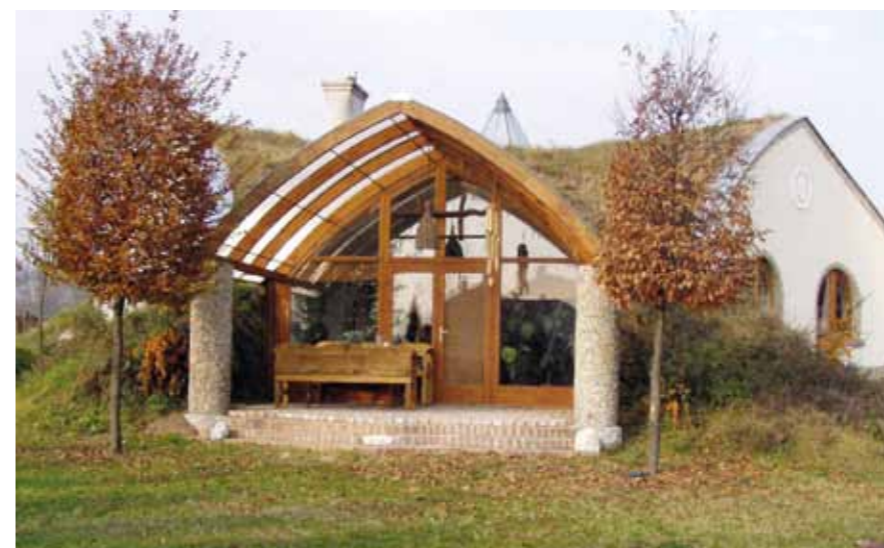
▼ Cementtel stabilizált vályogtéglából épült ház [építész: Hegedűs Zsolt]
